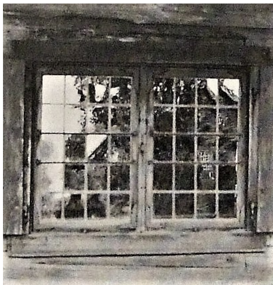
De eldste vinduene består av små glassruter innfattet i bly, hovedsakelig anvendt i tidsrommet 1650 til 1750, men flere steder anvendt til utpå 1800-tallet. I Åsenhuset, Bjerkreim finnes et blyglassvindu fra 1700-tallet.
